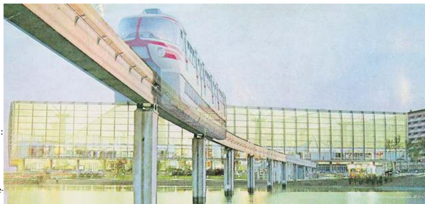
▲ Monorotaia La futuribile carrozza di fronte al Palazzo del Lavoro
